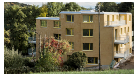
Video Ab Dezember ist in Leimbach ein Haus bezugsbereit, das für Menschen mit Multipler Chemikalien-Unverträglichkeit (MCS) gebaut wurde. Was macht dieses Gebäude aus? Mehr... Von Jvo Cukas 22.10.2013
